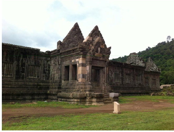
Travaux de restauration achevés. Juillet 2012.
