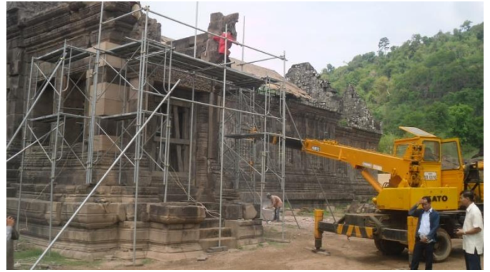
Restauration du porche. Mai 2012
